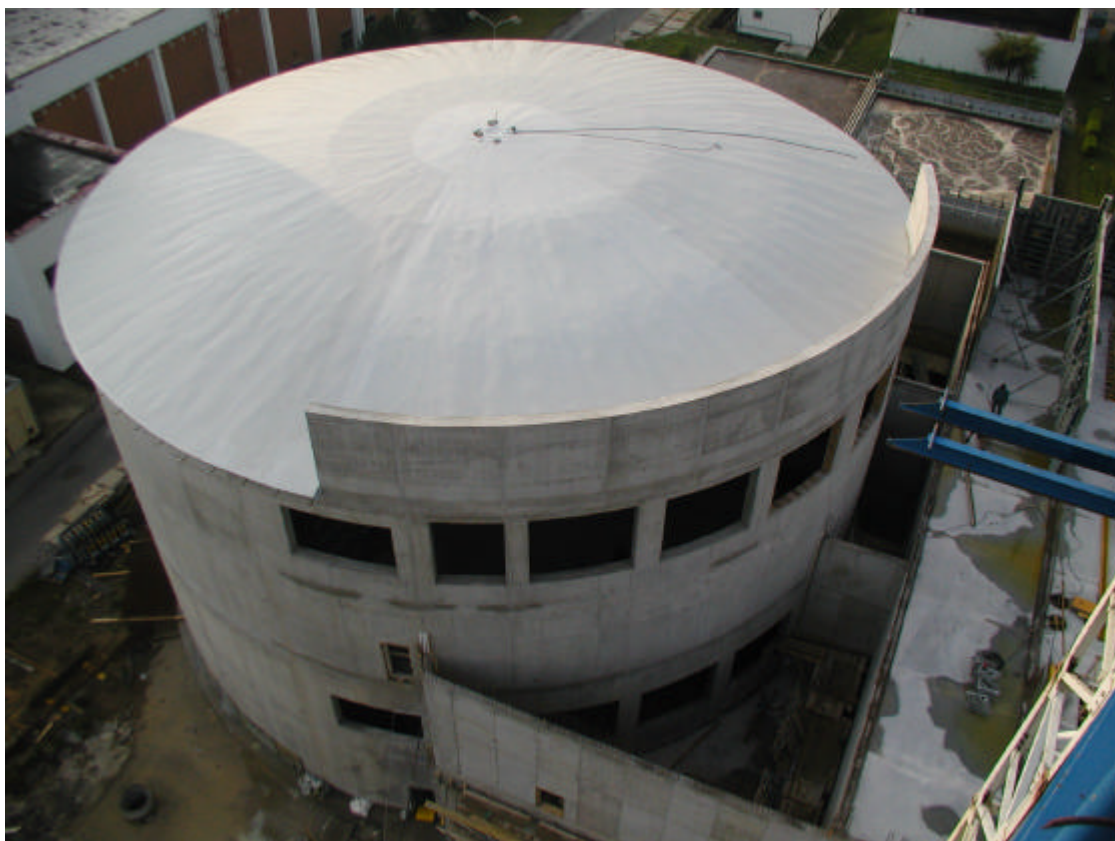
Obr.1 Pohled na válcovou část hvozdu v průběhu výstavby
