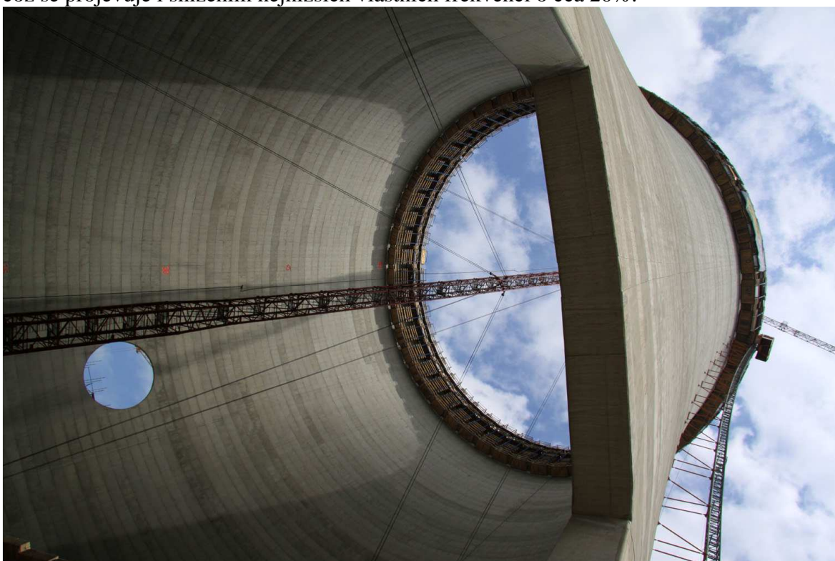
Obr. 3 CHV v Elektrárně Ledvice v době před dokončením tažení pláště
